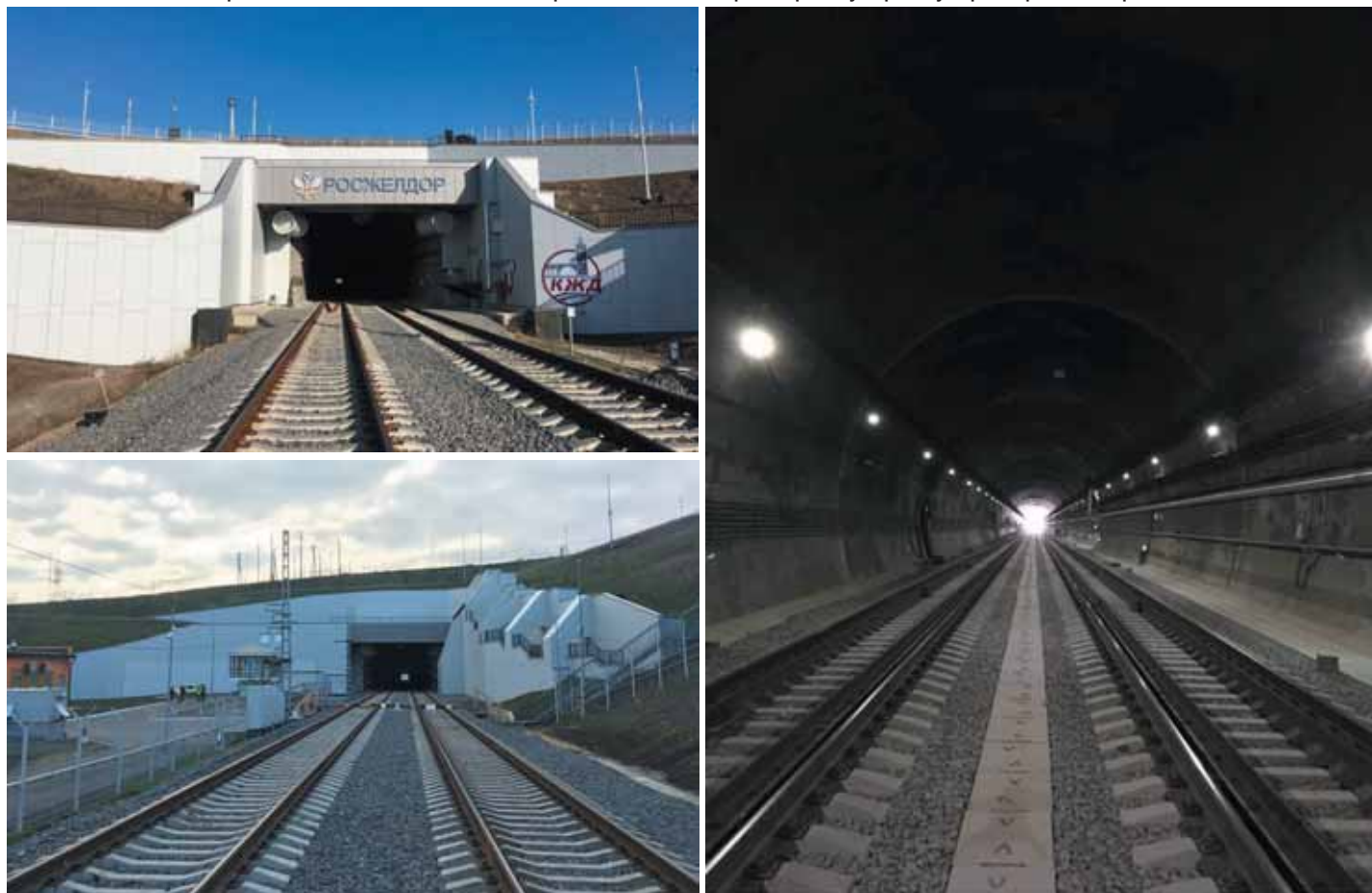
Рис. 4. Новый железнодорожный тоннель на 66 км железнодорожного подхода к транспортному переходу через Керченский пролив
