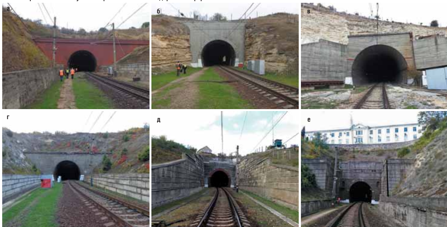
Рис. 1. Порталы тоннелей участка Крымской железной дороги Симферополь – Севастополь
